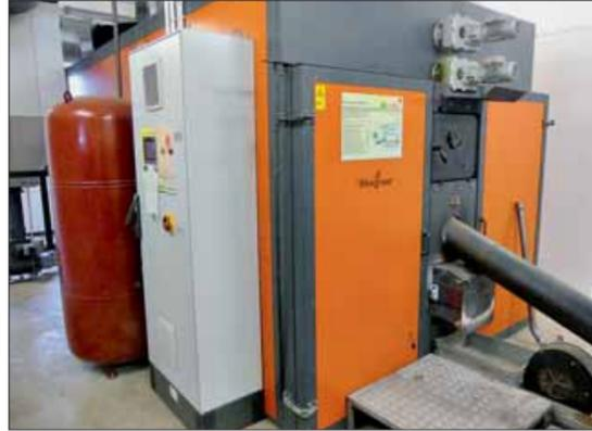
Der bisherige Hackschnitzelkessel von Heizomat bleibt in Betrieb. Da beide Kessel unterschiedliche Anforderungen an die Brennstoffstückigkeit stellen, gibt es zwei getrennte Bunker.
