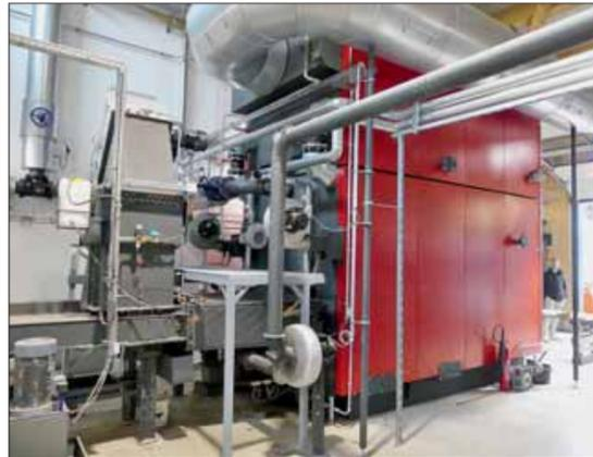
Der neue Kessel ist eine Vorschubrostfeuerung vom Typ „LCS-RV 1150/1300“ mit 1300 kW von Nolting.
