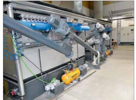
Aufgrund des hohen Volumenstroms wurden zwei Keramikfilter „NGFL 9150“ verbaut.
