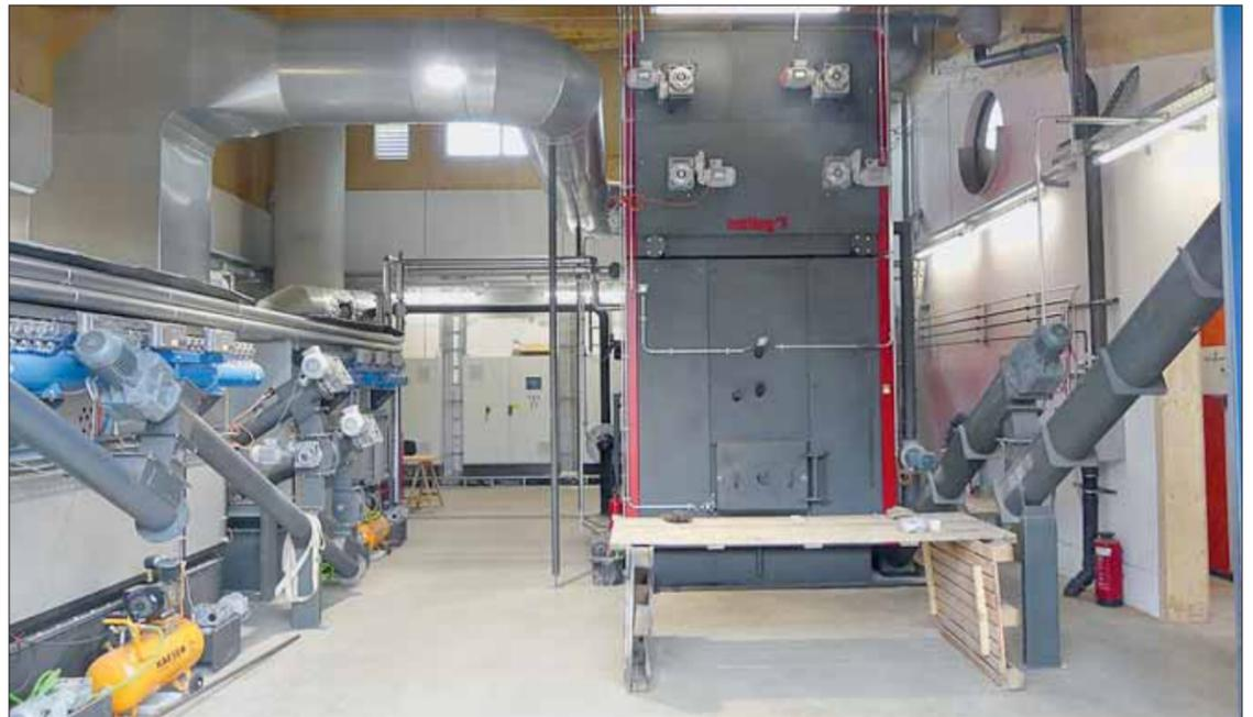
Mit dem neuen Kessel ist die Anlage auch weiterem Wachstum gewachsen. Links sind die Keramik-Filter zu sehen.
